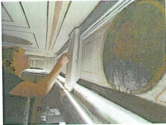
Foto 31: Sondiranje zgornjega pasu stene
