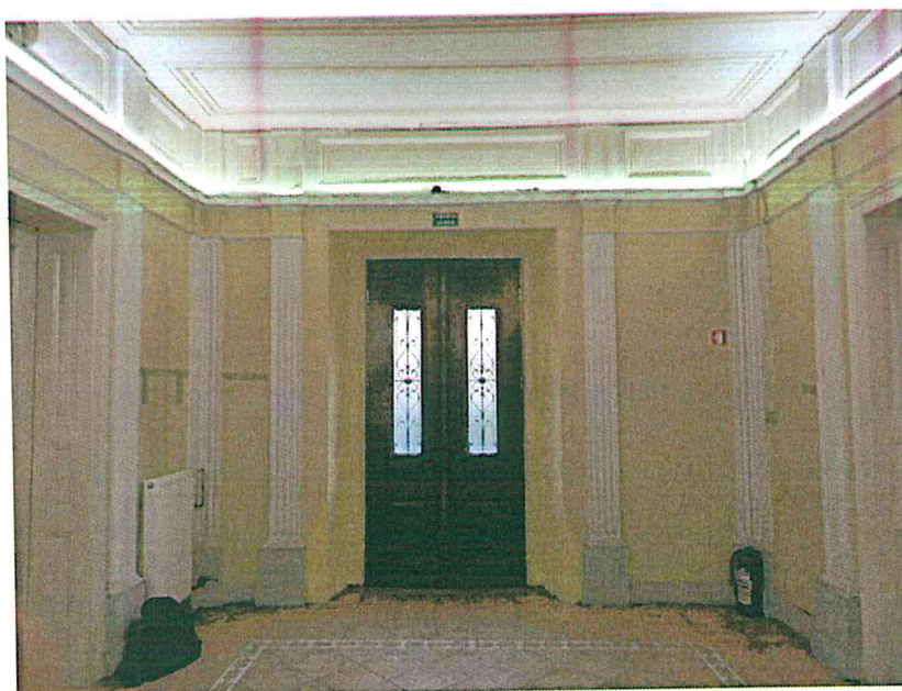
Foto 17: Južna stena z glavnim vhodom, Skazova hiša
