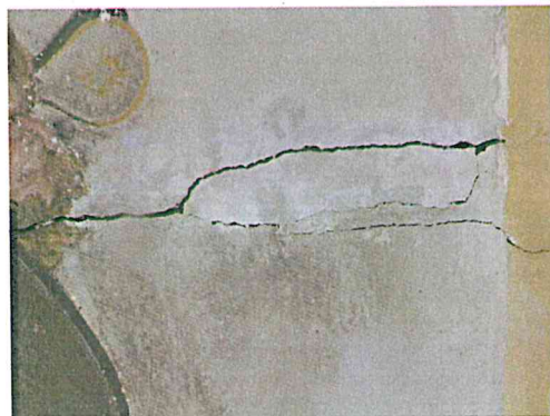
Foto 57: Večje razpoke na stropu
